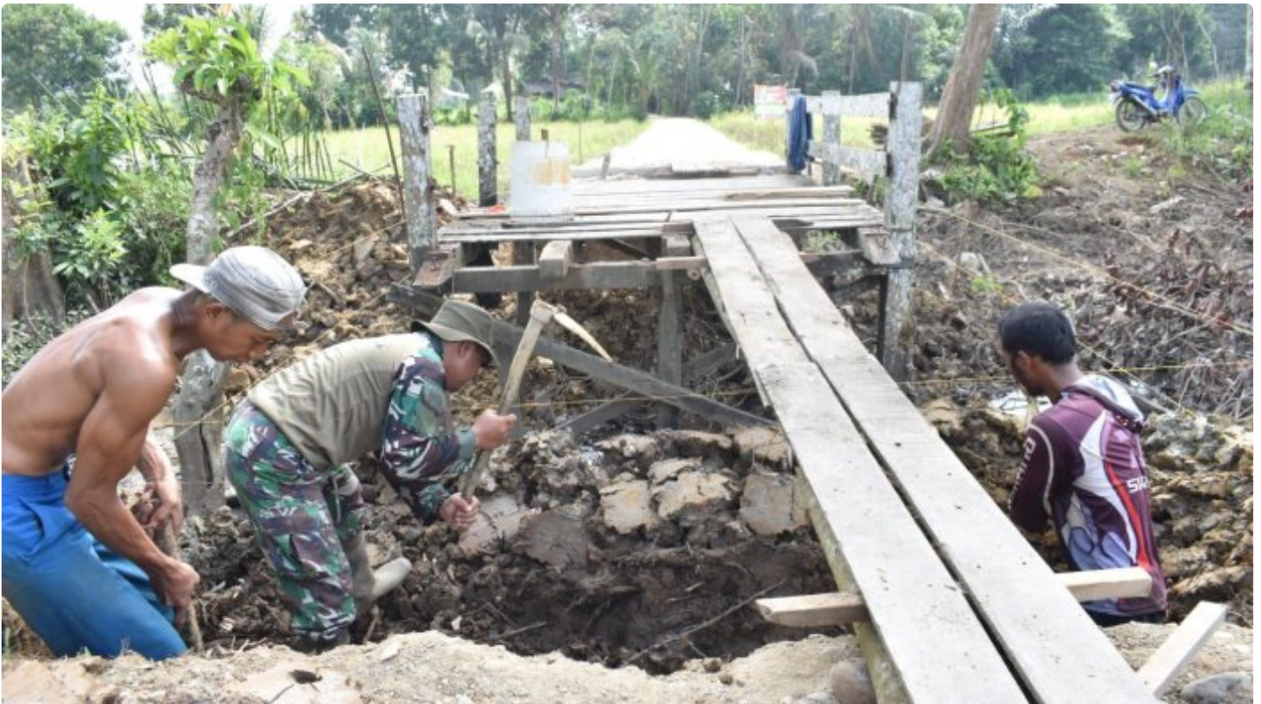
Abutment Jembatan Dikerjakan Satgas TMMMD Ke-116 Kodim 1002/HST
