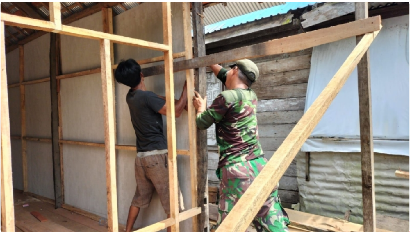
Pemasangan Dinding Rehab RTLH, Kodim 1002/HST
