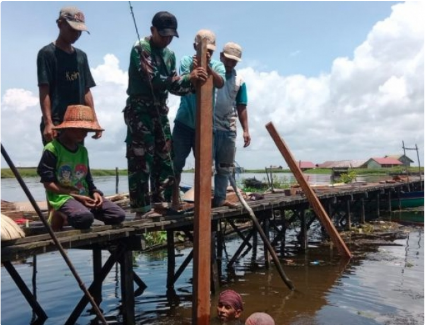
Pemasangan Tiang Penampungan Air
