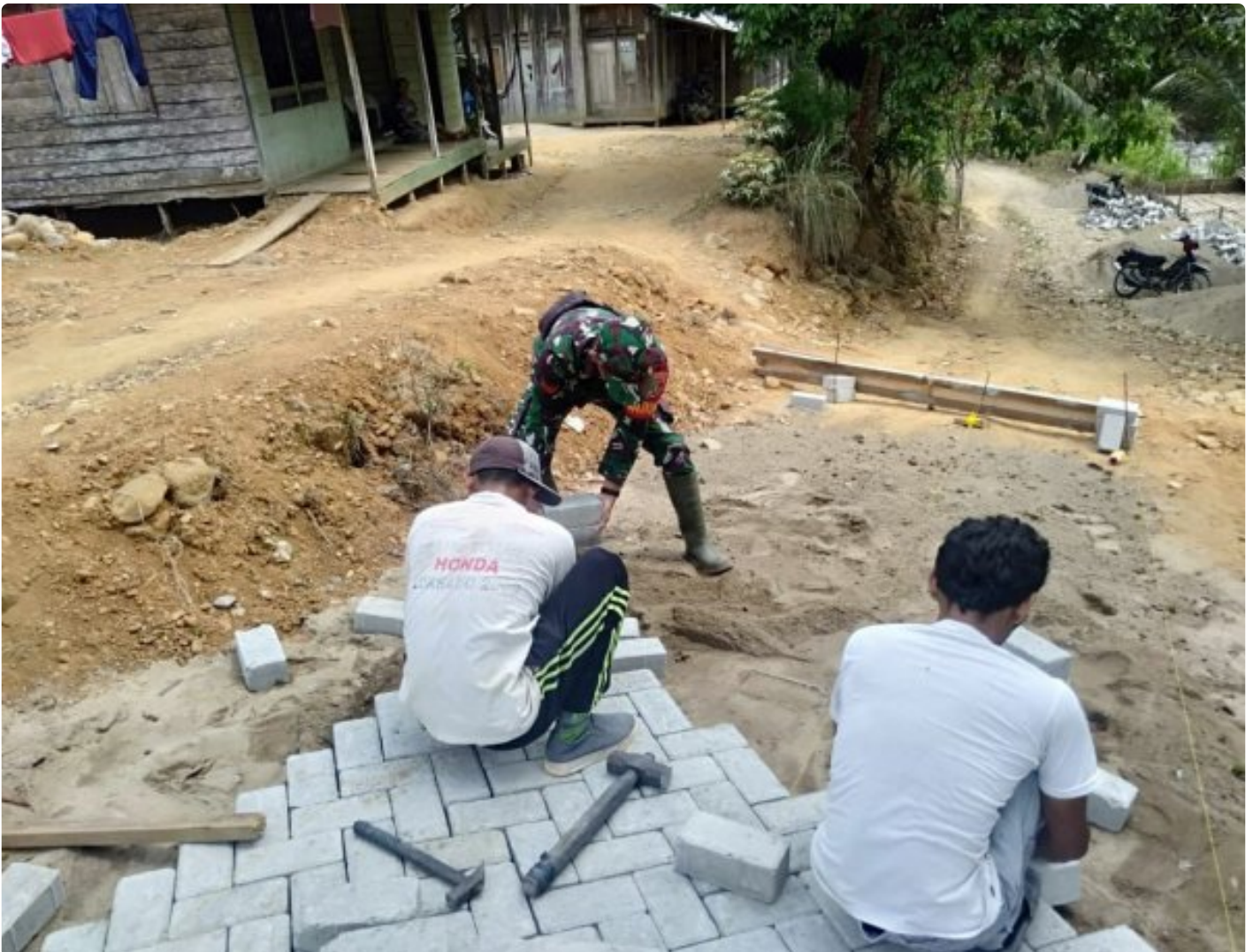
Koptu Erli Bersama Warga Gotong-royong Bangun Jalan Di Desa Hinas Kiri
