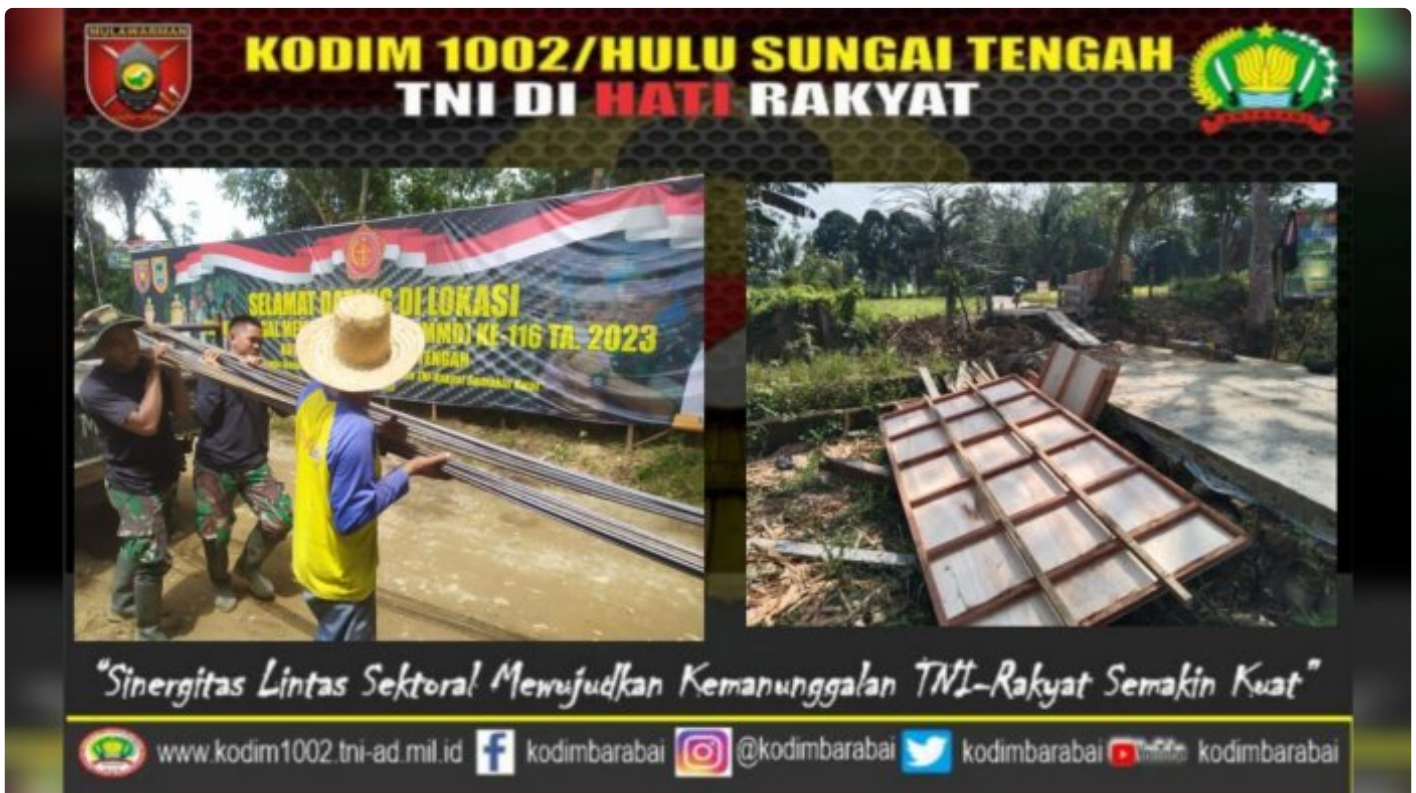
Material Pembuatan Abutment Jembatan Didatangkan
