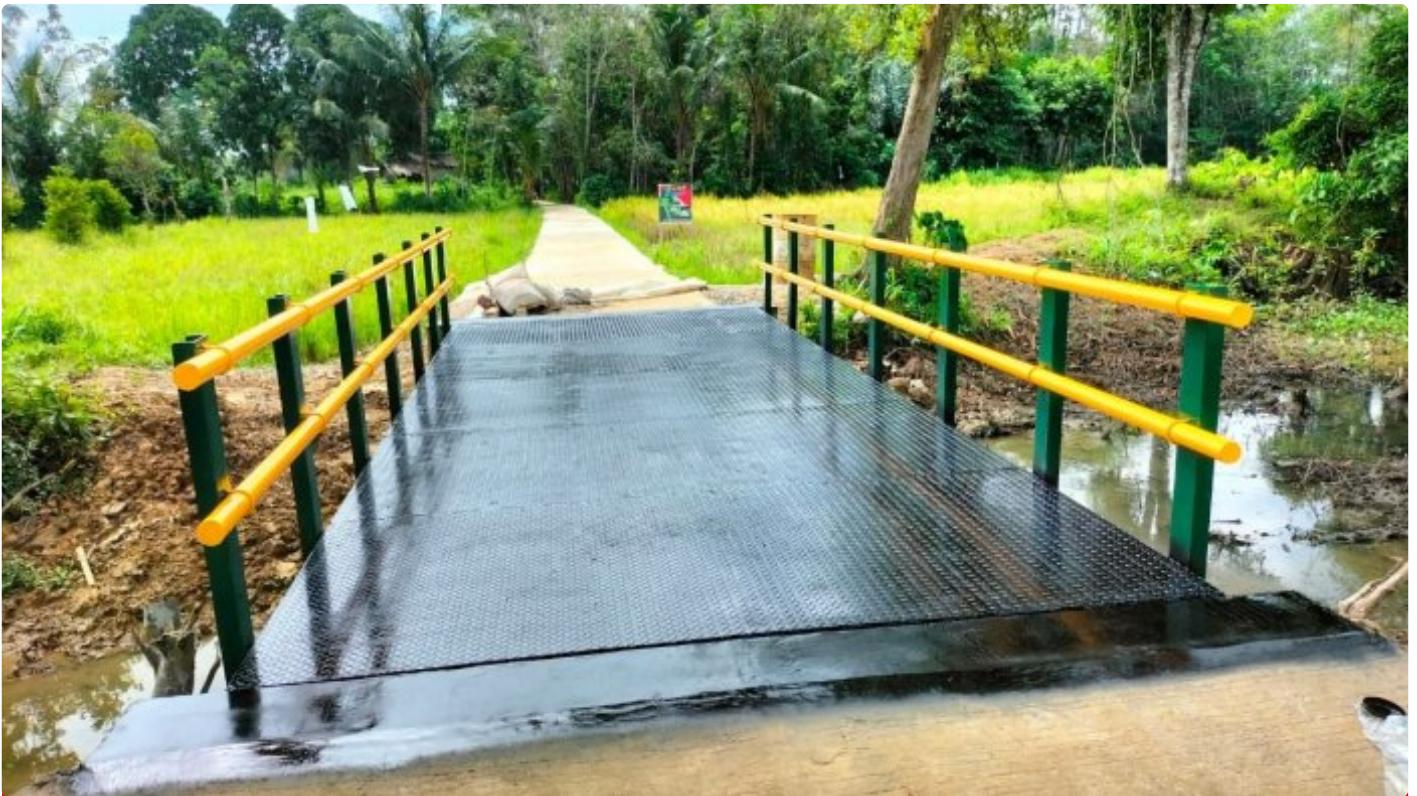
Pembangunan Jembatan Besi Rampung Seratus Persen
