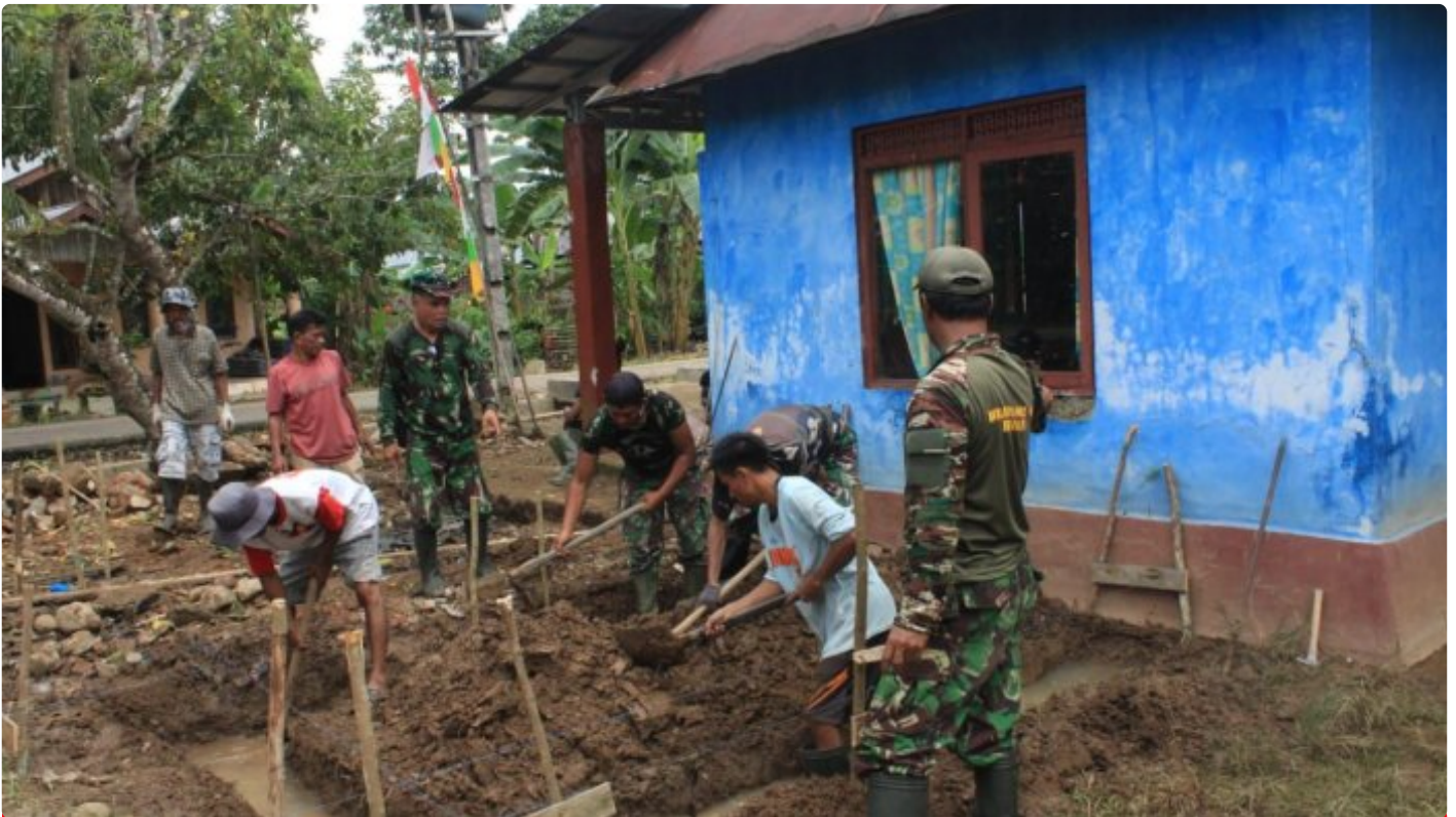
Rehab Musholla Darul Hair Mulai Dikerjakan Oleh Satgas TMMD ke-116 Kodim 1002/HST
