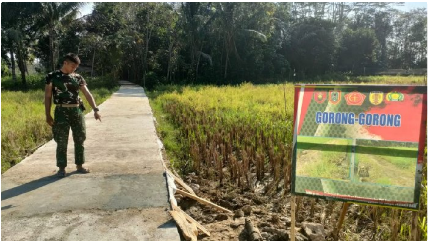
Sasaran Fisik Gorong-gorong 1 TMMD Ke-116 Kodim 1002/HST Rampung 100 Persen
